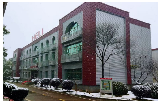
办公楼外墙改造
